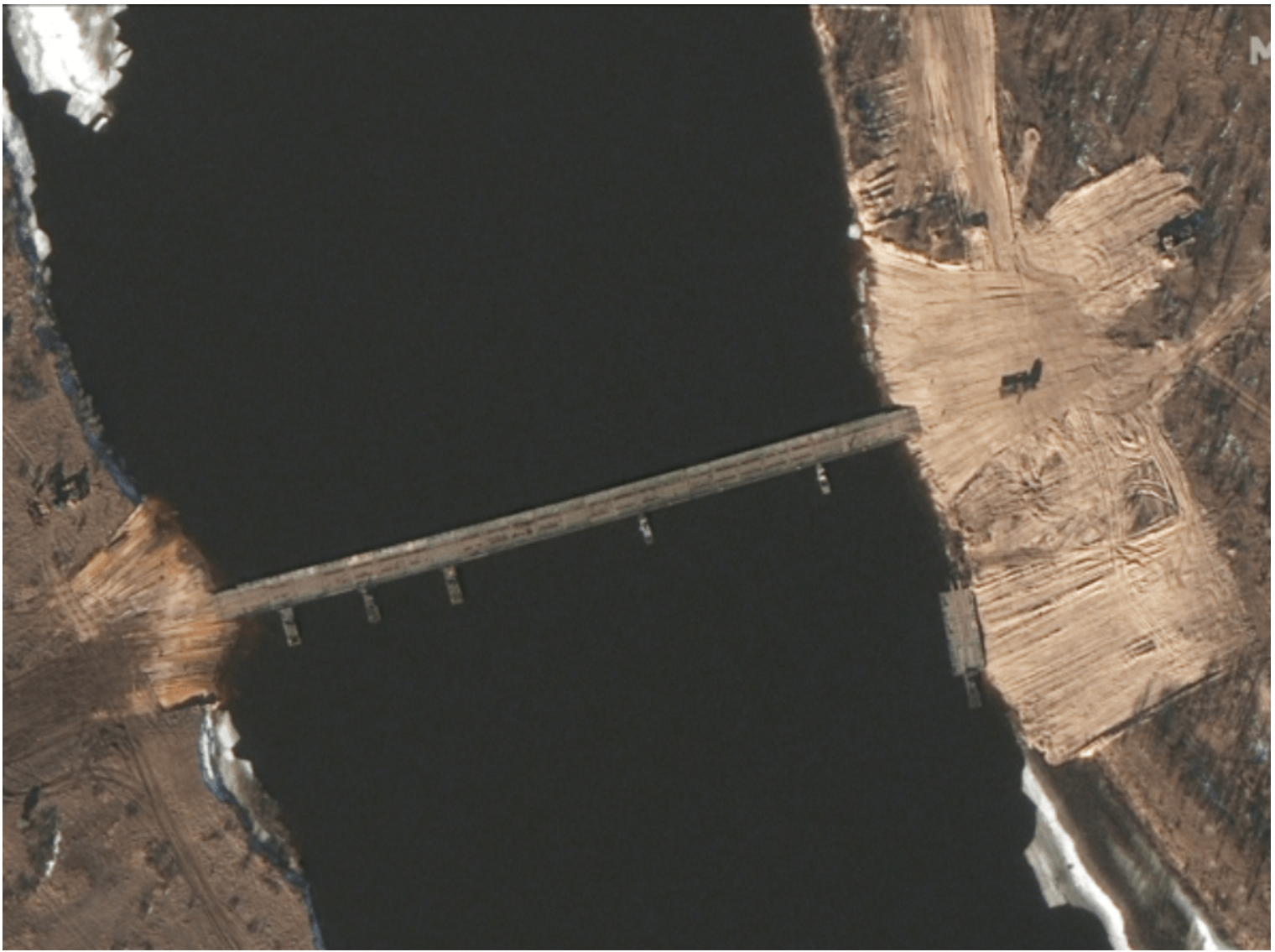
Fiume Pripyat – Le Immagini della Cnn che mostrano il ponte costruito e poi rimosso durante le esercitazioni Russia-Bielorussia
