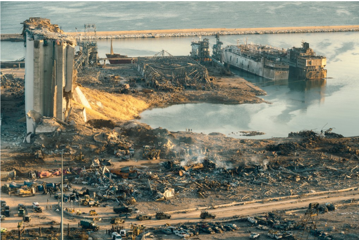
Foto – Beirut, Libano – 5 Agosto 2020: Veduta aerea del porto di Beirut completamente distrutto
